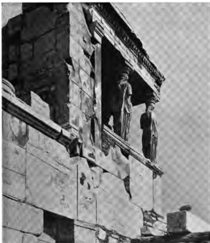
Fig. 27. — Tribune de l'Erechthéion. Jeunes vierges soutenant allègrement la corniche architravée et le plafond à caissons. Vue prise du Cecropion.
